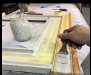
GRUNTOWANIE / BASE PRIMING
