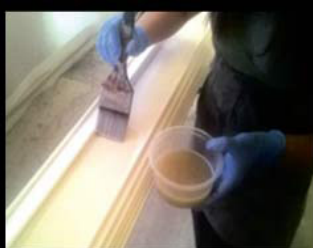
GRUNTOWANIE / BASE PRIMING
