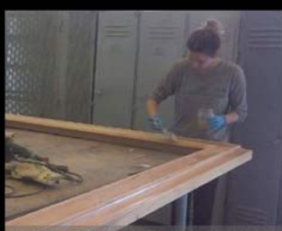
GRUNTOWANIE / BASE PRIMING
